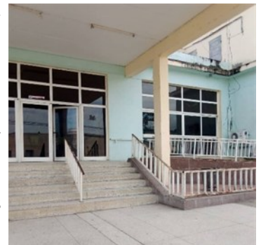
Hospital. Foto ICLEP
