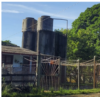
Fuente de abasto Aguas Claras: Foto ICLEP
